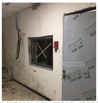
机房砌体应采用密度较高的红砖或灰砂砖实砌,并应用水泥砂浆砌筑,墙体厚度应不少于**240mm**[]砌筑时保证墙体的平整度、垂直度符合规范要求。灰缝应做到横平竖直,保证砌筑砂浆的密实度、饱满度在90%以上,不得有贯通缝或墙内空隙,否则容易导致射线直穿。
